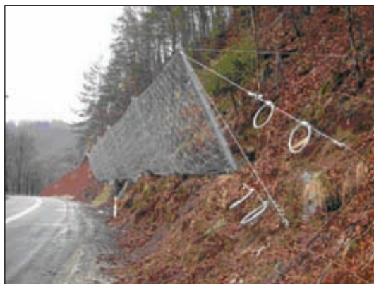
To nowatorskie rozwiązanie wykonała szwajcarska firma Geobrugg
