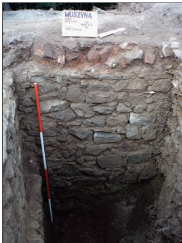
Ryc. 11. Zachodni mur obwodowy – widok fundamentu w narożniku z murem północnym
