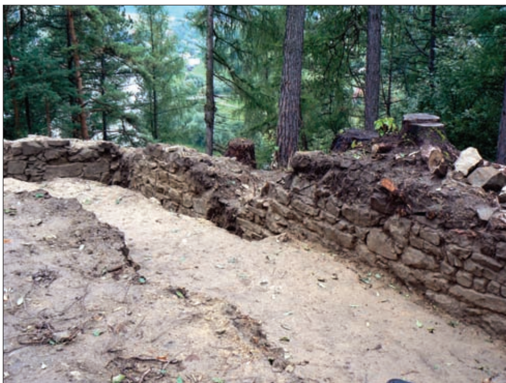
Ryc. 8. Zachodni mur obwodowy – lico wewnętrzne – widok od północy
