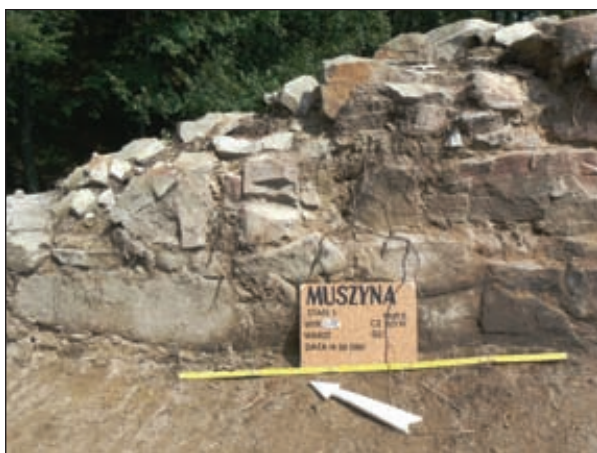
Ryc. 2. Zachowany fragment lica wewnętrznego wschodniego muru obwodowego z widocznymi śladami działania ognia
