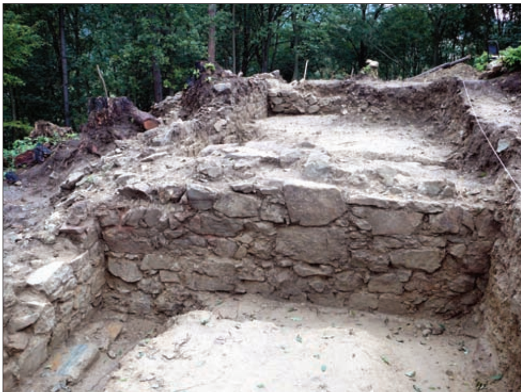
Ryc. 9. Zachodni mur obwodowy – lico wewnętrzne – widok od południa. Na pierwszym planie mur działowy 2
