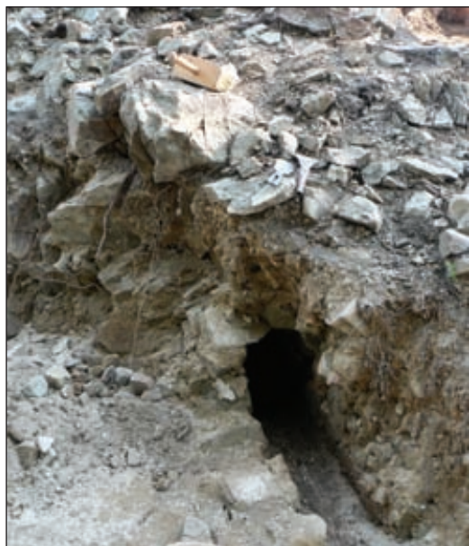
Ryc. 3. Kanał we wnętrzu wschodniego muru obwodowego
