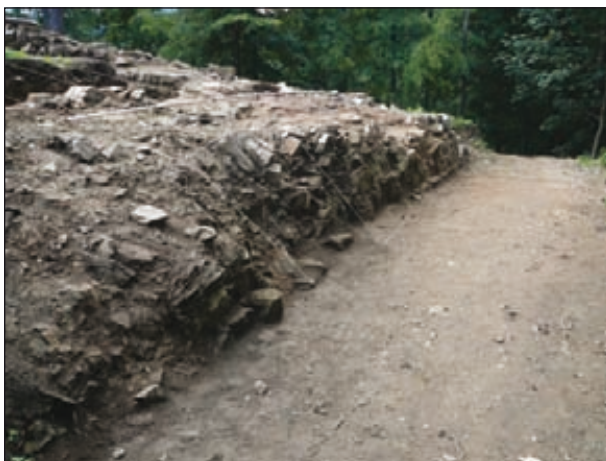
11. Lico zewnętrzne północnego muru obronnego – widok od północnego wschodu (obie fot. B. Chudzińska)
