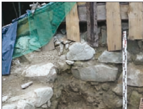
8. Północno-wschodni narożnik murów obwodowych od strony dziedzińca (fot. B. Chudzińska)
