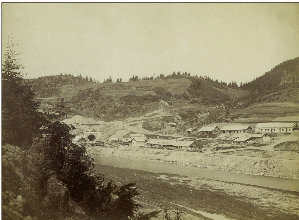
Roboty budowlane przed otwarciem „drogi żelaznej” do Muszyny (rok 1876). Widoczny wjazd do tunelu od strony Andrzejówki (fot. ze zbiorów „Almanachu Muszyny”)
